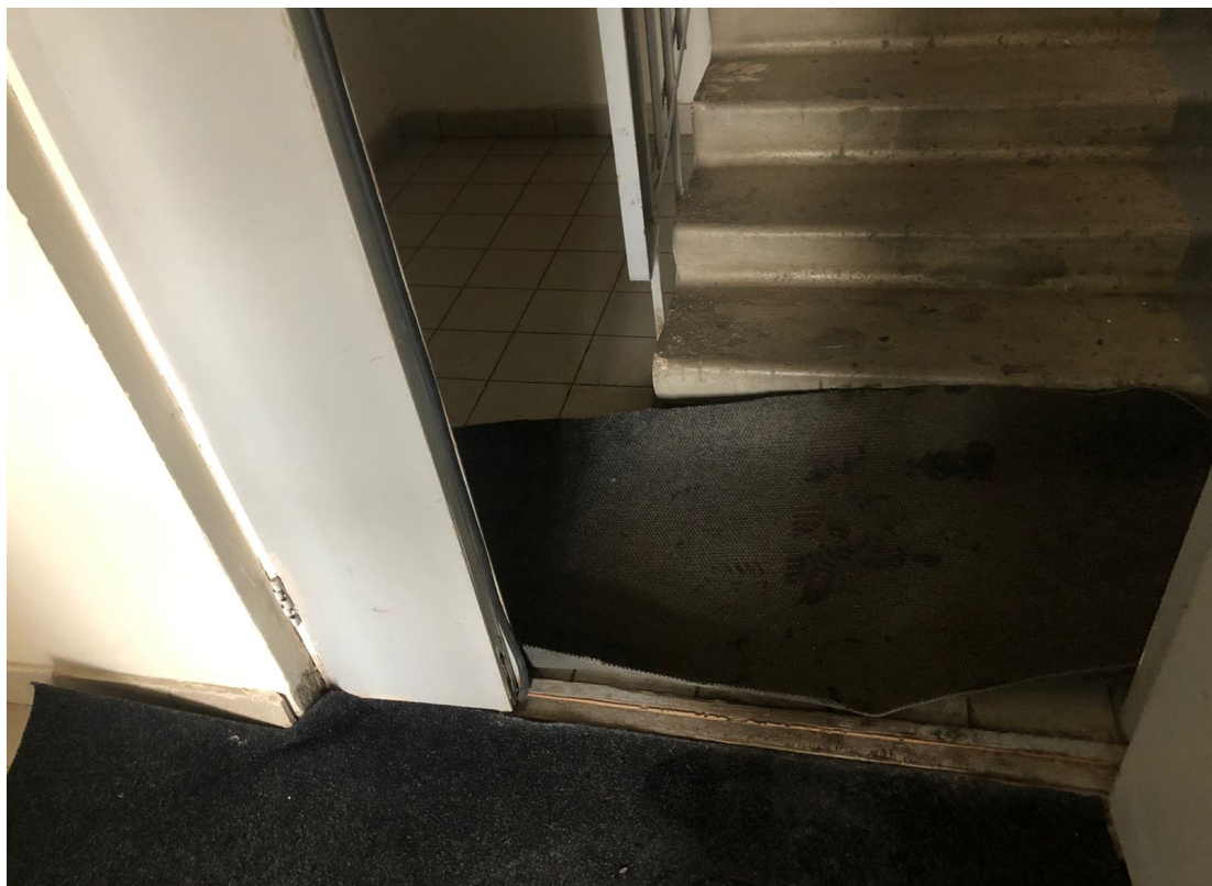
Монтаж грязезащитного покрытия
